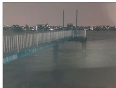
排水樋管周辺状況(当日)
