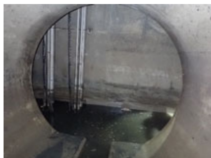
最下流部マンホール
