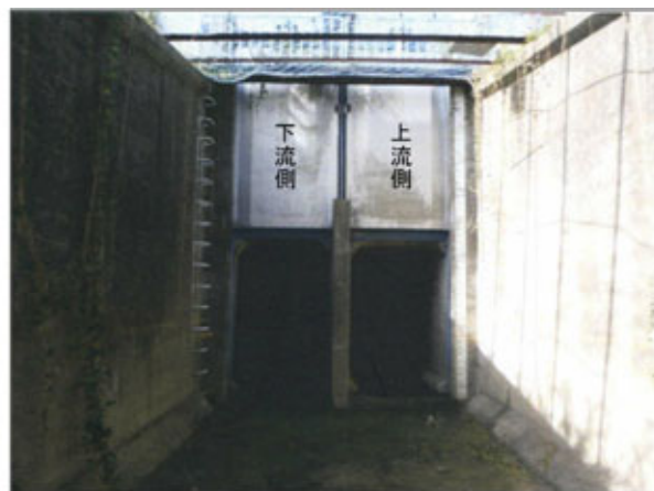
10月10日点検状況
