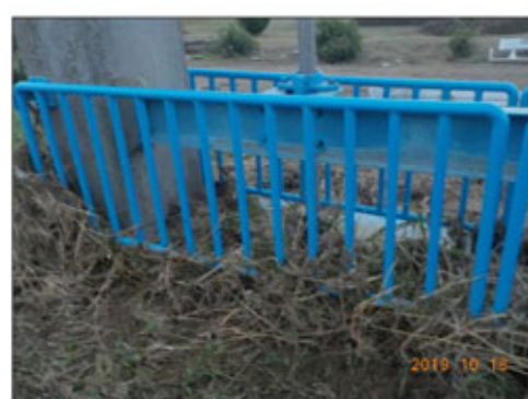
扉体上部状況(台風後)
