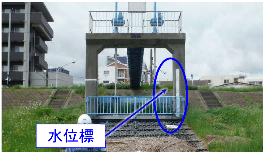
排水樋管部水位標
