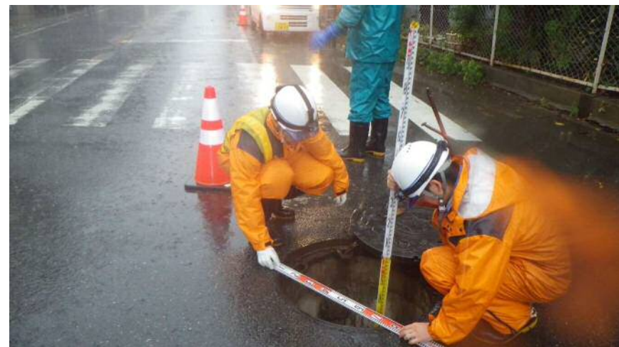
マンホール部 水位計測
