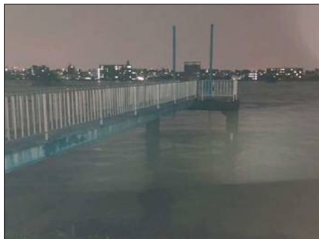
写真:排水樋管周辺状況(当時)
