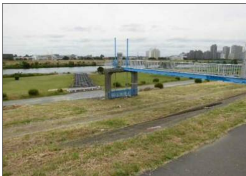
写真:排水樋管周辺状況(平常時)
