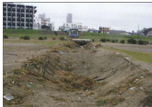
写真:排水樋管周辺状況(台風後)
