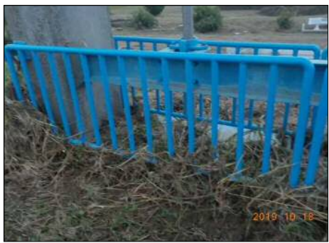
写真:扉体上部状況(台風後)
