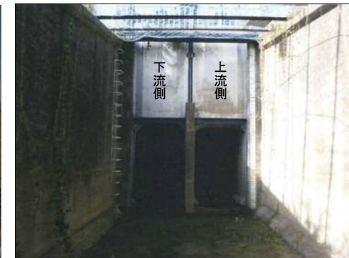
写真: 10月10日点検状況
