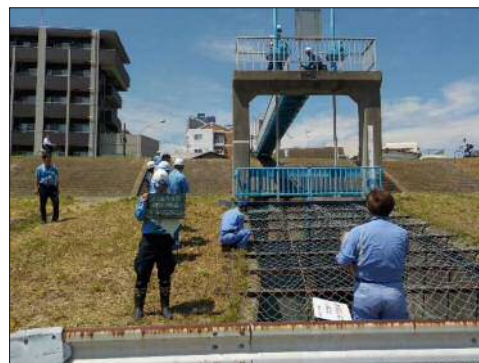
写真: 河川管理者による検査状況
