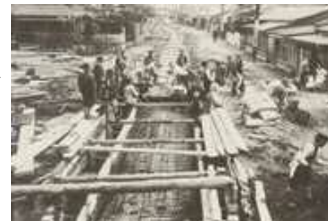
昭和初期の下水管きょの整備
