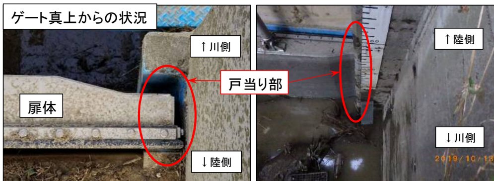
写真:扉体及び戸当り部
