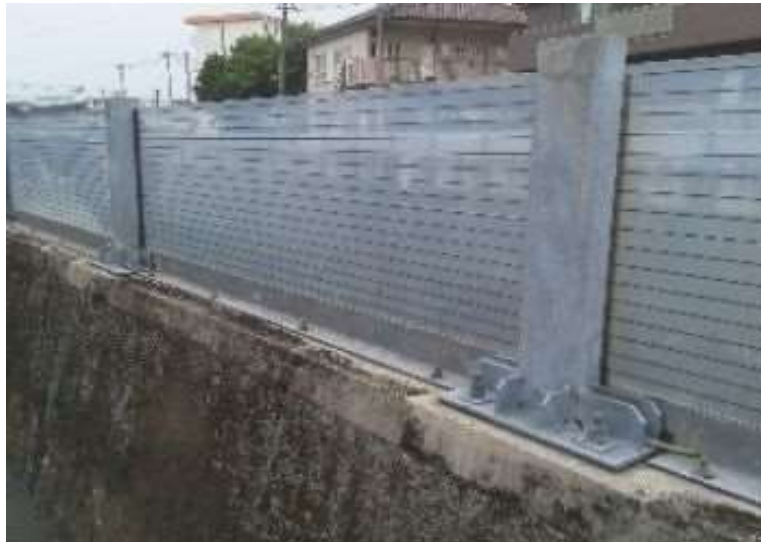
図 7-4-3 アクリル板の補修
