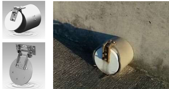
図 7-4-2 フラップゲート(設置事例)
