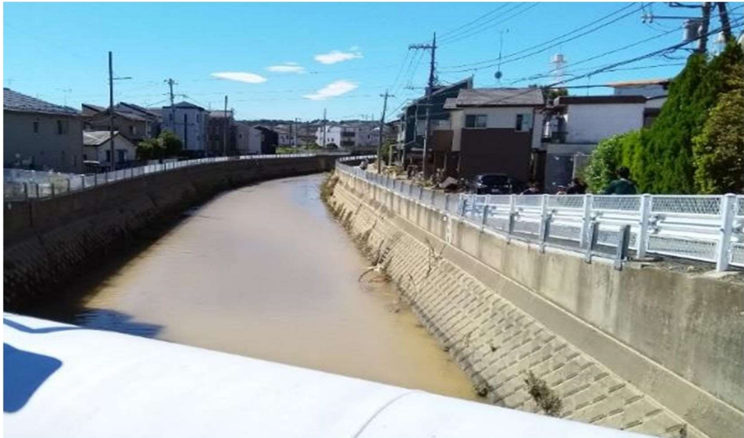
図 4-3-1 三沢川(JR 南武線三沢川橋梁周辺)
