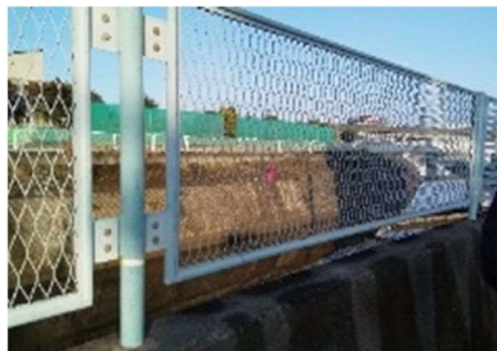
既存パラペット護岸
