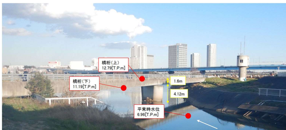
図 6-2-1 橋桁の高さ関係
