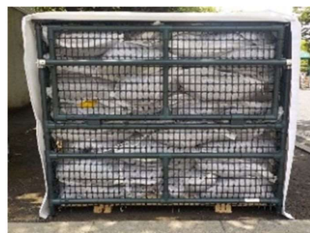
図 7-4-6 土のうステーション(設置事例)
