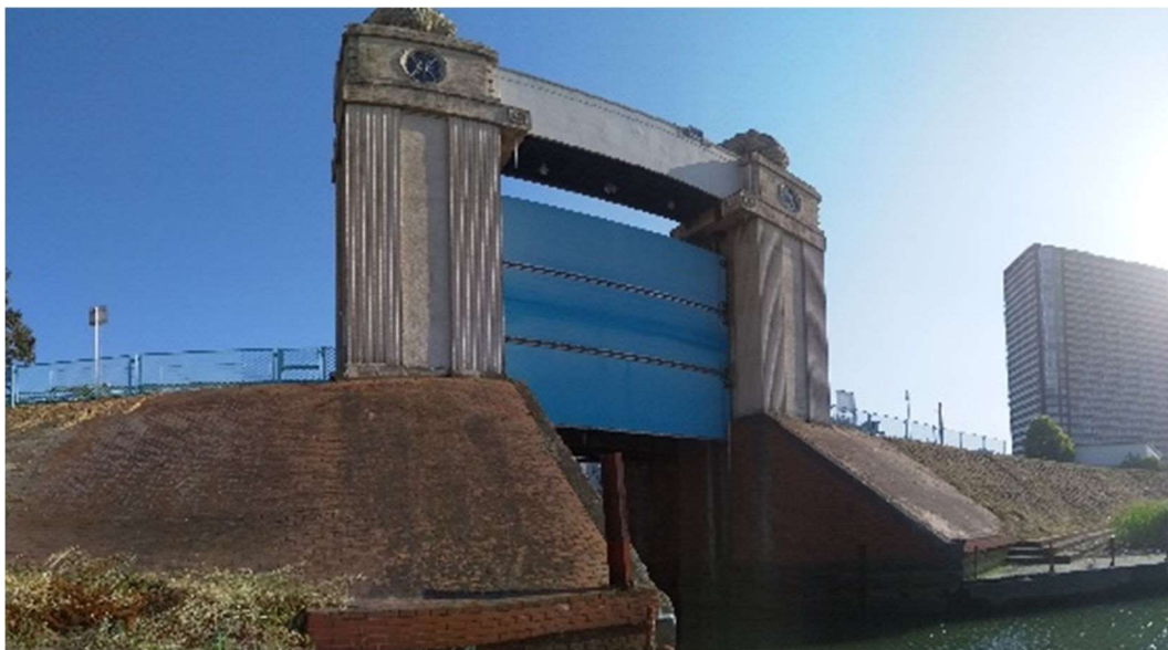
図 4-1-1 河港水門(川崎区港町周辺)
