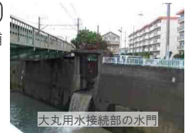
大丸用水接続部の水門
