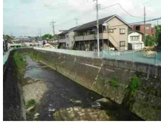
整備後の平瀬川
