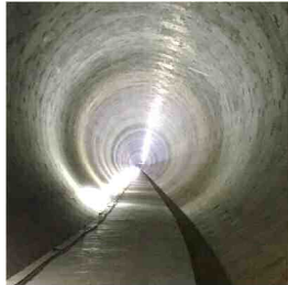
五反田川放水路
