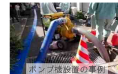
ポンプ機設置の事例
