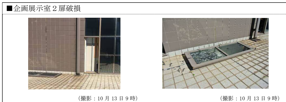
図 10：市民ミュージアム地階以外の被害状況（写真）
