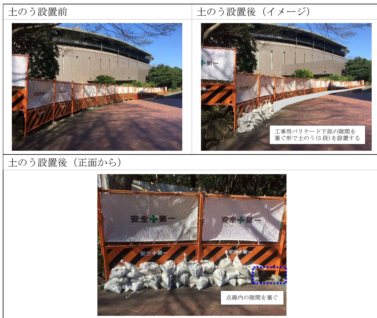
図 13：工事用バリケードを利用した土のうの設置イメージ
