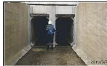
樋管ゲート写真
