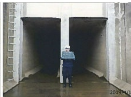
樋管ゲート写真
