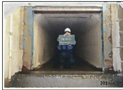
樋管ゲート写真
