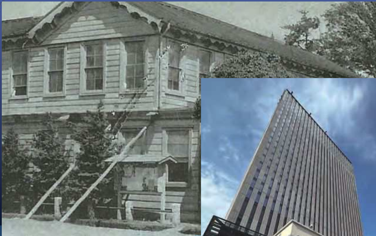
川崎市制が始まったころの川崎市役所。 庁舎は震災被害を受けた川崎町の建物につかえ棒で 応急処置したものだった。
