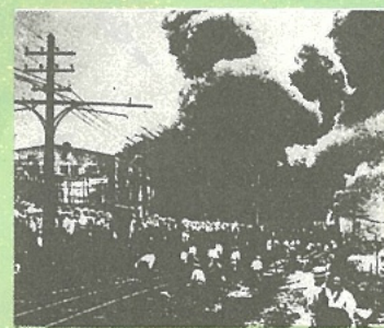
関東大震災・横浜駅付近(大震災写真集・神奈川県・復刻版より)
