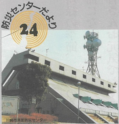
川崎市南部防災センター
