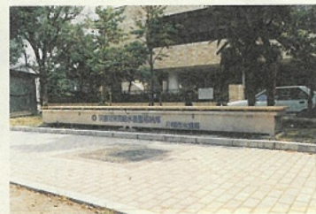
災害対策用給水装置格納庫(ベンチ式)
