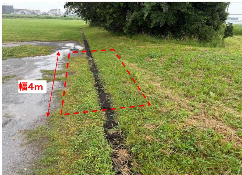
谷状に低くなっているグレーチング部分を消防車等の大型車両が安全に通行できるよう、鉄板で養生をする。
