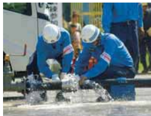
漏水管の修復訓練を行う
