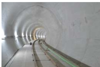
大師河原貯留管の整備
