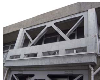
建築構造物の耐震化（ブレースの設置）
