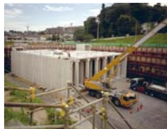
施設の耐震化工事
