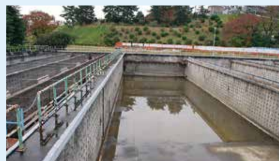
長沢浄水場沈んでん池(昭和40年~)
