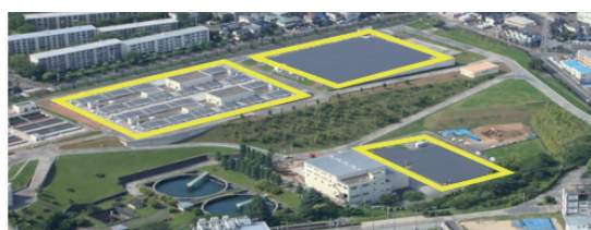
長沢浄水場太陽光発電設備
