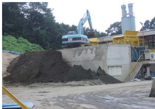
改良土プラント
