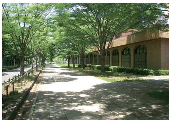
麻生水処理センター
