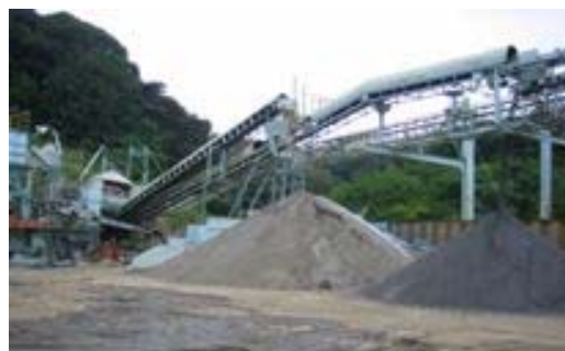
粒状改良土プラント
