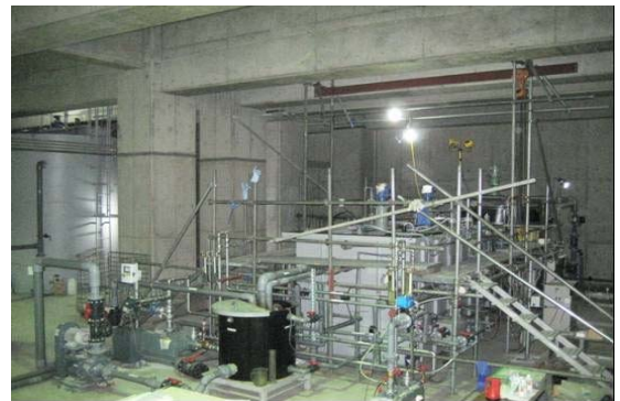
高度処理実験プラント
