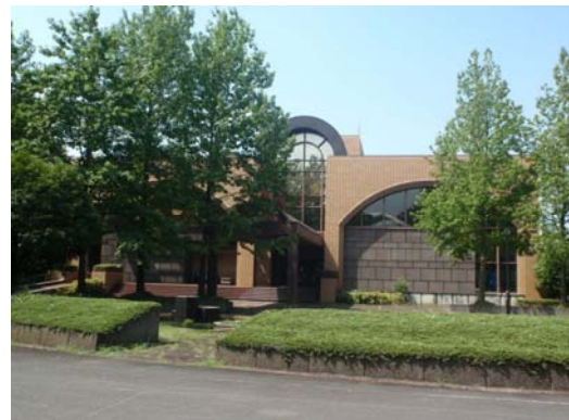
麻生水処理センター
