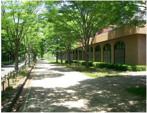
麻生水処理センター
