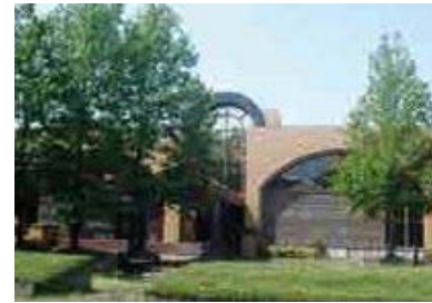
麻生水処理センター
