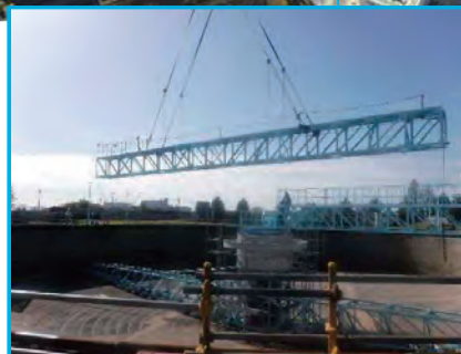
長沢浄水場 第1沈殿池 (工業用水道施設)
