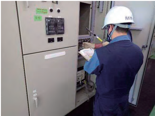
施設の点検(電気設備定期点検)
