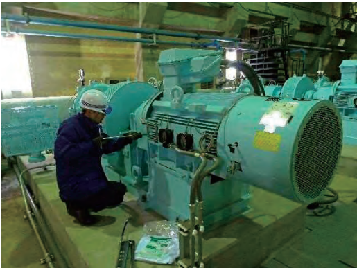
施設の点検(ポンプ定期点検)
