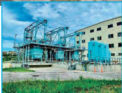
長沢浄水場 排水処理施設 2次濃縮装置 (水道・工業用水道施設)
