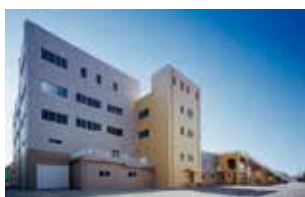
入江崎水処理センター西系再構築事業
