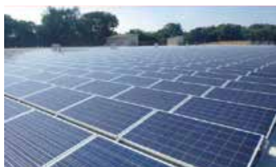
生田配水池太陽光発電設備
