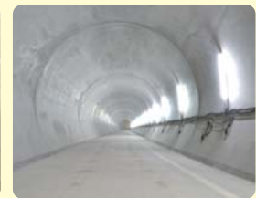
大師河原貯留管
