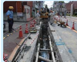
水道管布設替工事
