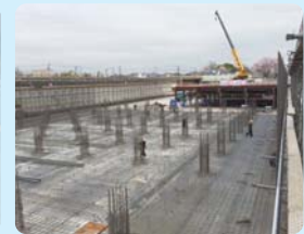
基幹施設(末吉配水池)の更新工事
