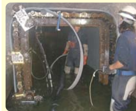
管きよの更生による重要な管きよの耐震化
