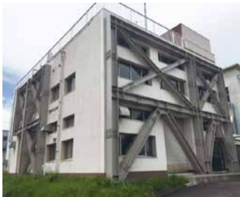
観音川ポンプ場管理棟の耐震化
