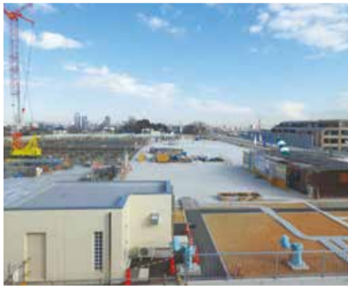
末吉配水池の更新・耐震化
