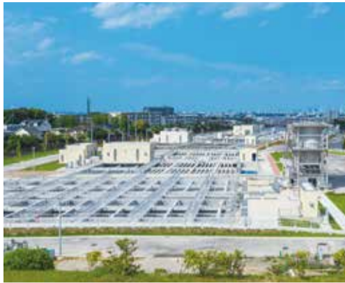
長沢浄水場の更新・耐震化
