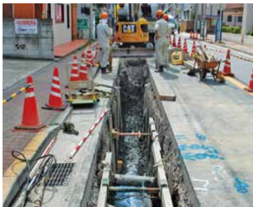
配水管の更新・耐震化
