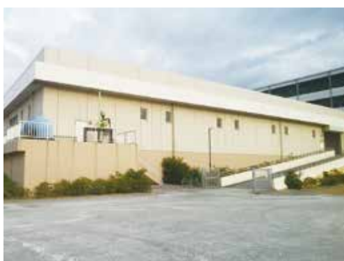
入江崎水処理センター西系施設の再構築事業にあわせた津波対策 (津波浸水深を考慮した床高設定による耐水化)
