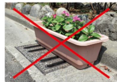
プランターで雨水ますをふさいでいる様子
