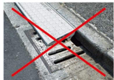
車乗り入れブロックで雨水ますをふさいでいる様子
