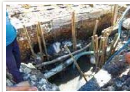
漏水修理工事
