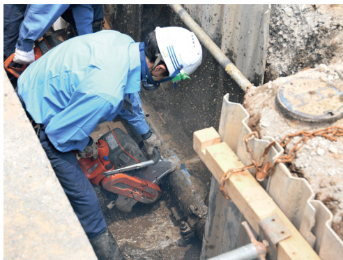
エンジンカッターで古い管を切断
