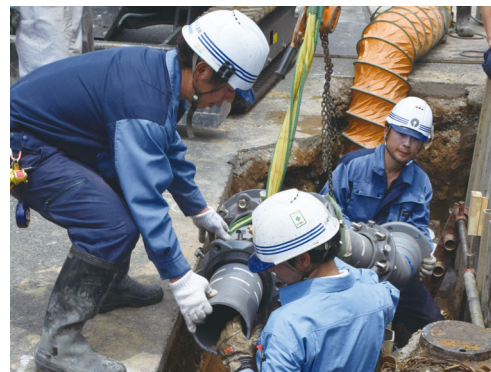
新しい耐震管を布設
