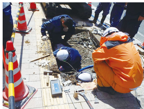
熊本地震での漏水修理
