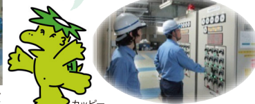
設備点検の様子
