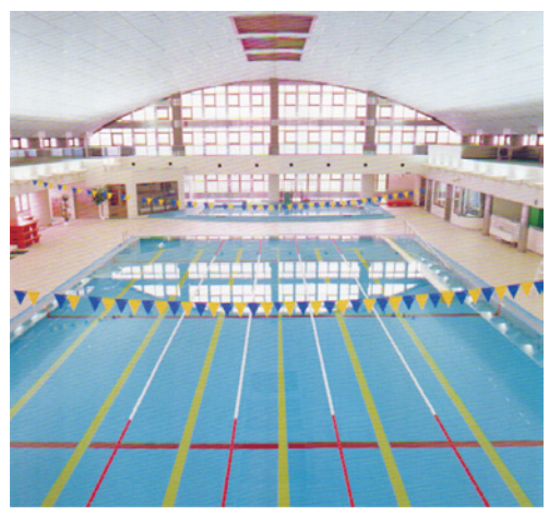
入江崎余熱利用プール
