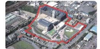
入江崎総合スラッジセンター
