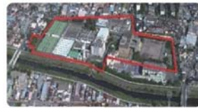
加瀬水処理センター
