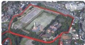
麻生水処理センター
