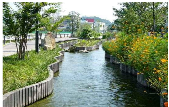
江川せせらぎ水路
