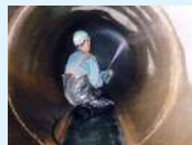
下水管きよの清掃
