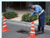
漏水調査の様子
