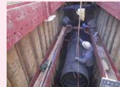
雨水管布設工事
