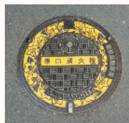
臨時給水所として使用する 消火栓の鉄蓋
