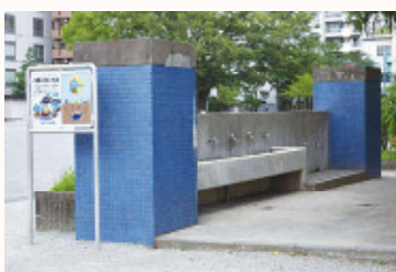
開設不要型応急給水拠点 (既設給水栓利用型)
