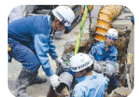
耐震管布設の様子
