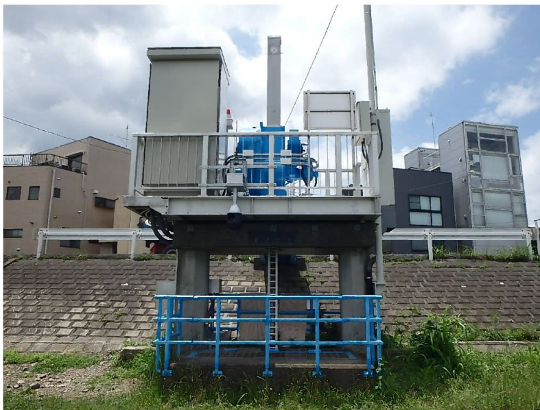
(5) 宇奈根排水樋管ゲート（フラップ機構付ゲート）
