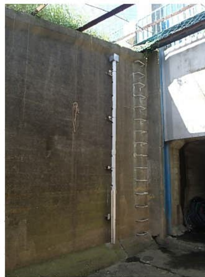
外水位計（河川水位）
