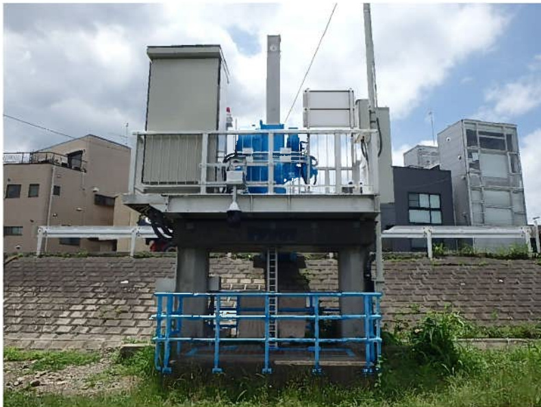
(5) 宇奈根排水樋管ゲート（フラップ機構付ゲート）
