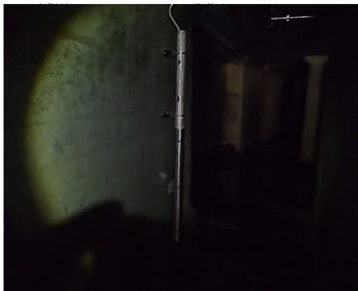
内水位計（管きよ内水位）
