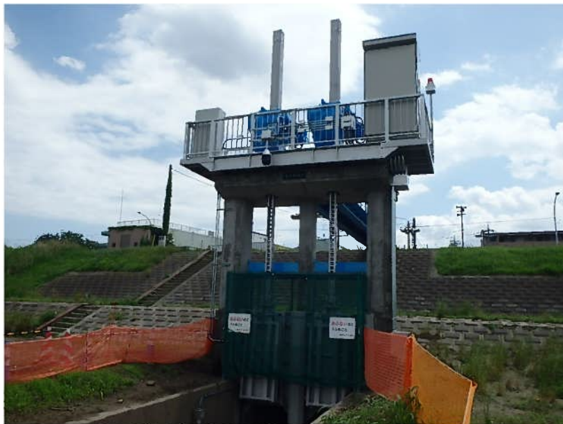
(5) 宇奈根排水樋管ゲート（フラップ機構付ゲート）
