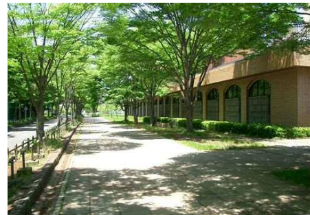
麻生水処理センター
