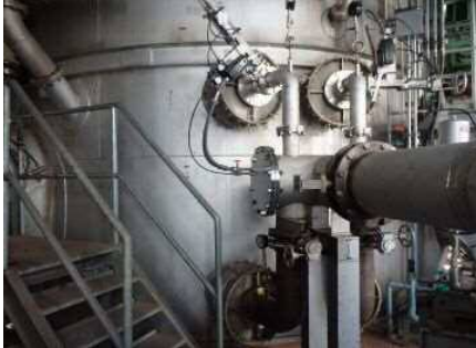
一酸化二窒素と窒素酸化物の削減効果を確認する試験設備
