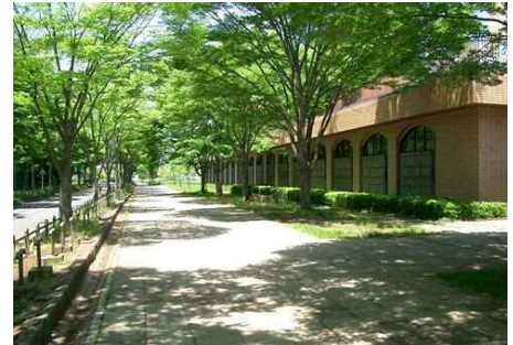
麻生水処理センター
