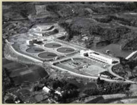
完成当時の長沢浄水場
