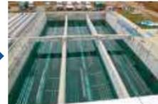
原水と凝集剤(ポリ塩化アルミニウム)を混ぜフロックと呼ばれるかたまりにして濁質を沈めて取り除きます。
