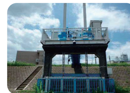
排水樋管ゲートの電動化（令和2年7月稼働開始）
