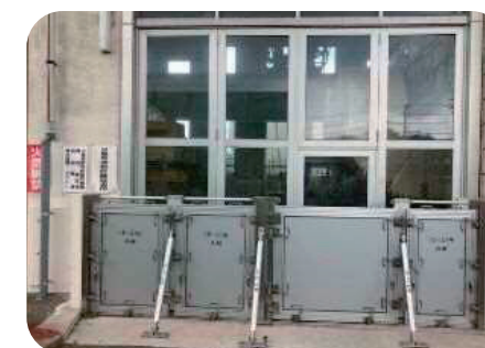
施設の耐水化（止水板）
