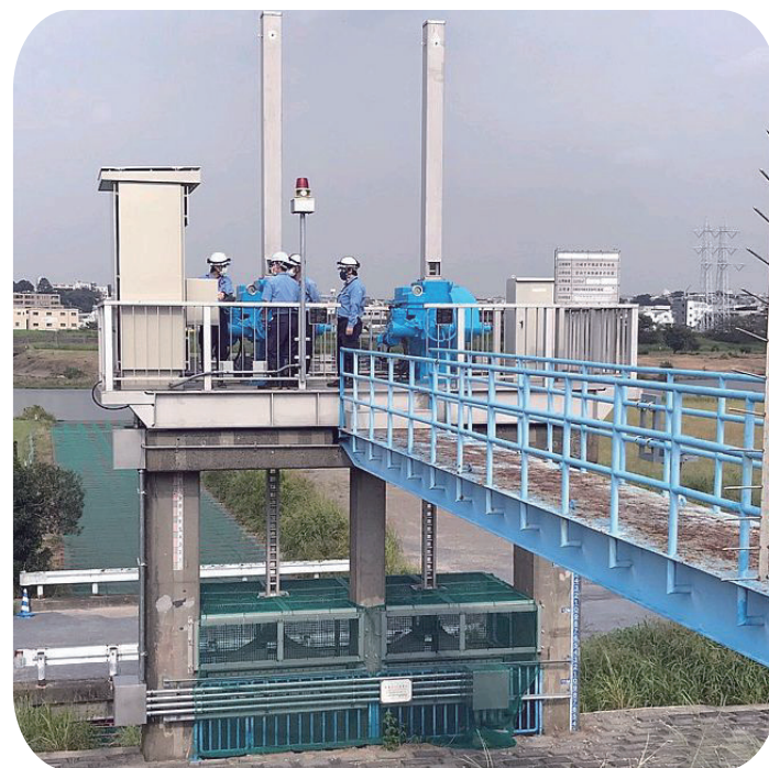
排水樋管ゲートの操作訓練状況
