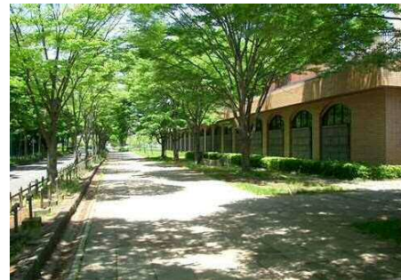
麻生水処理センター
