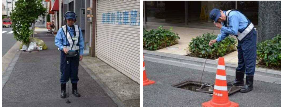
漏水調査の様子
