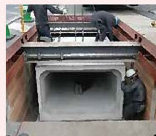
雨水管布設工事
