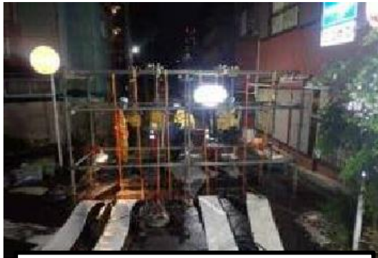
排水ホース布設
