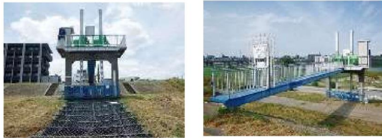
排水樋管ゲートの改良
