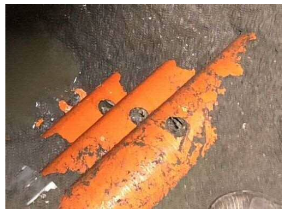
写真 3.2 破損状況（拡大）
