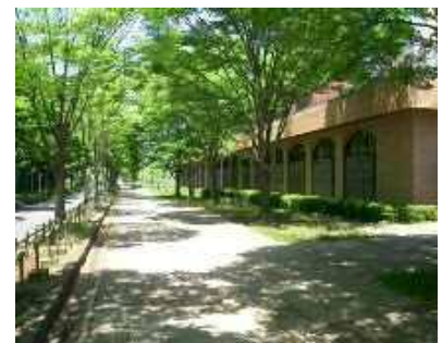
麻生水処理センター
